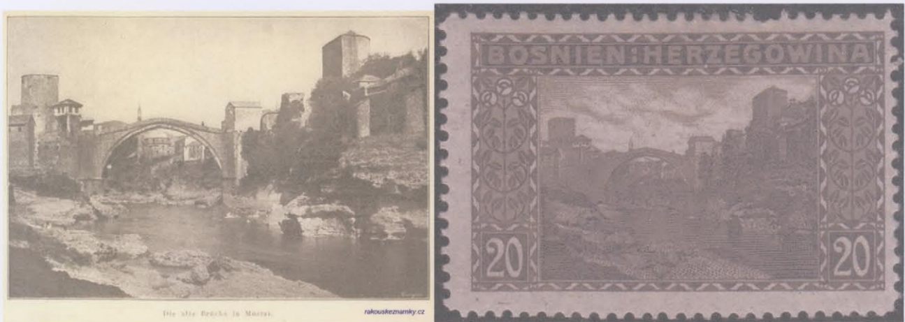
Obr. 6 Most v Mostaru, přesná předloha
